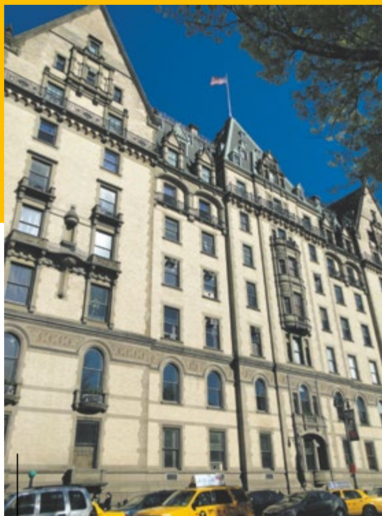
Kamienica jest piękna. Dziwnym rozwiązaniem jest natomiast montaż klimatyzatorów na elewacji tego wyjątkowego architektonicznie budynku
