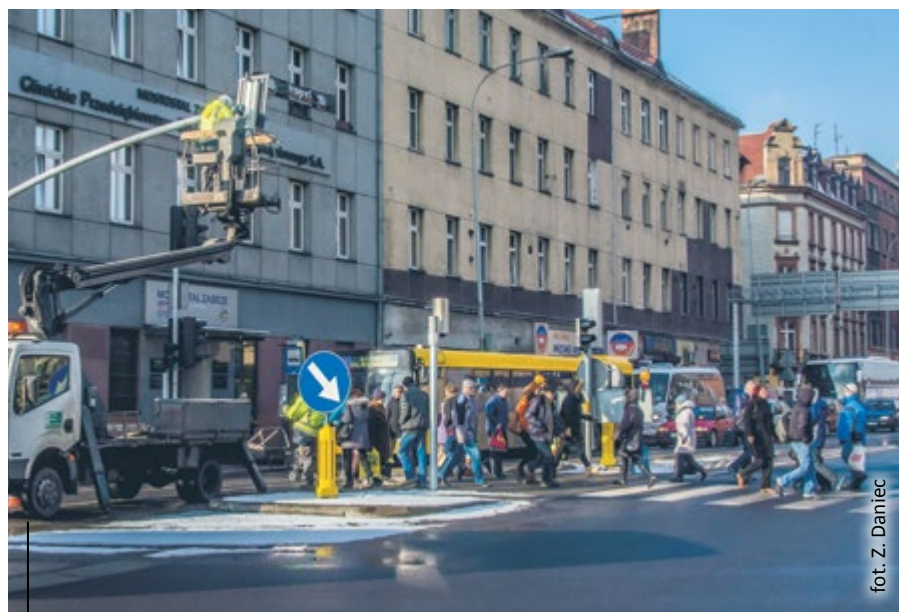
ZDM na bieżąco modernizuje oświetlenie i oznakowanie przejść dla pieszych
