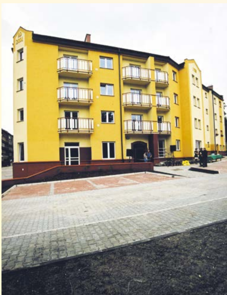
Pierwszy budynek TBS I przy ul. I. Daszyńskiego. Zdjęcie z 27 lipca 2001 r.
