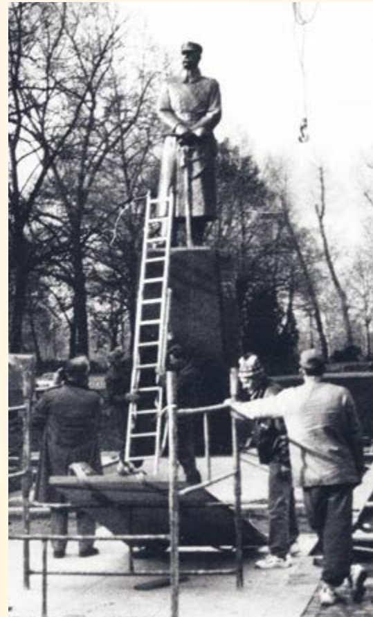
Budowa pomnika marszałka Józefa Piłsudskiego. Odświeżenie monumentu miało miejsce 11 listopada
