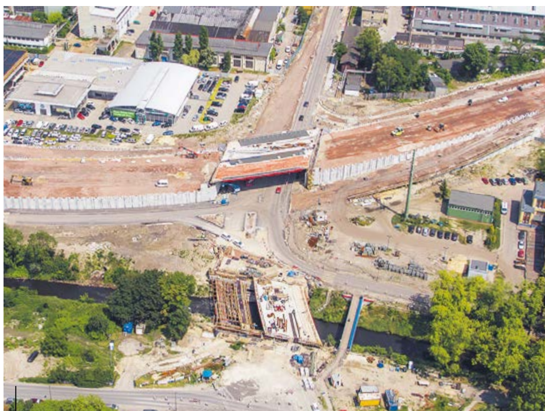
Nad ul. Jana Śliwki stoi już wiadukt. Obecnie trwa budowa murów oporowych i nasypów, oraz nowego mostu nad Kłodnicą
