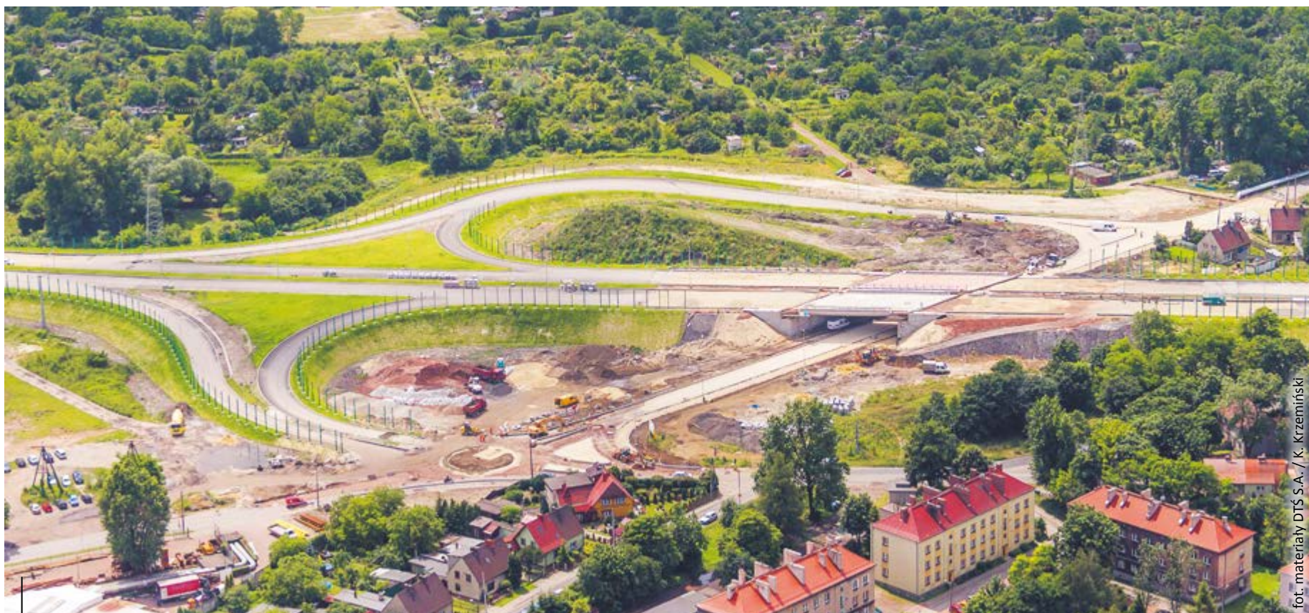
Kolejny węzeł drogowy na budowanej DTŚ powstaje przy ul. Królewskiej Tamy. Trwa także kompleksowa przebudowa fragmentu tej ulicy
