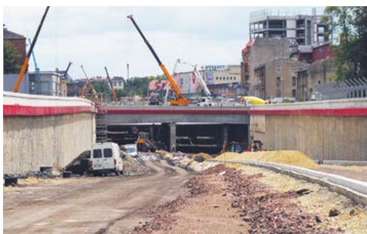
Projekt „Budowa Drogowej Trasy Średnicowej, odcinek G2” współfinansowany jest ze środków Programu Operacyjnego Infrastruktura i Środowisko na lata 2007 – 2013 www.pois.gov.pl
