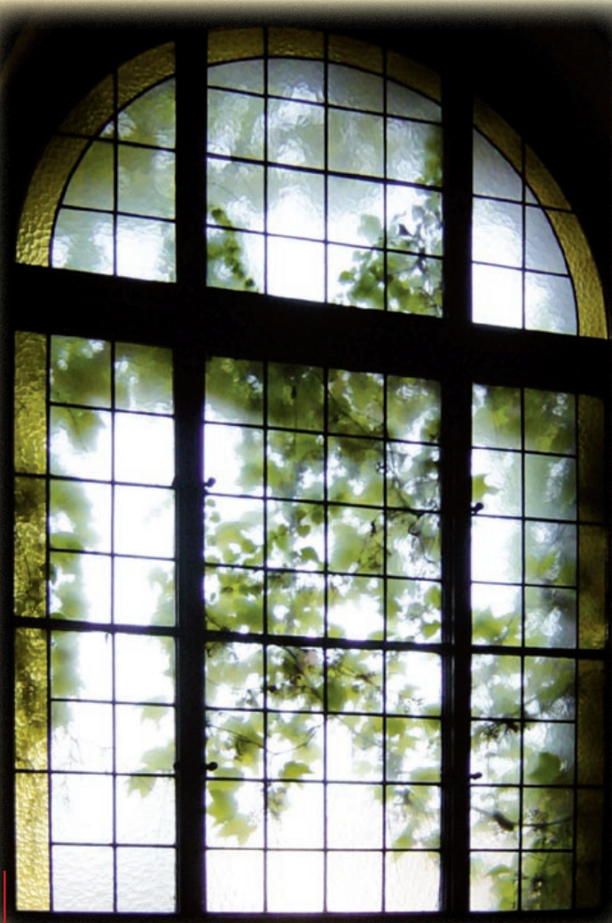
Okno w budynku sądu przy ulicy Wieczorka
